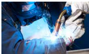
Наплавка металла на повреждённый инструмент (MAG-сварка)
